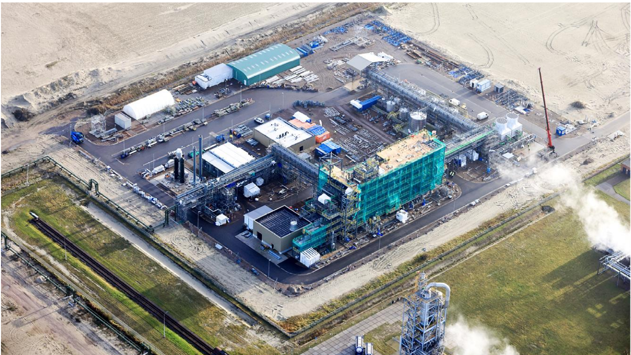
Avantium in aanbouw
